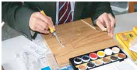
フローリングの傷補修
