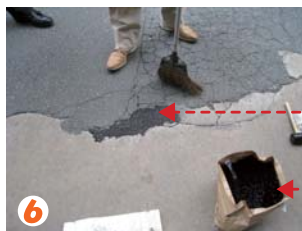
6 施工完了です。
